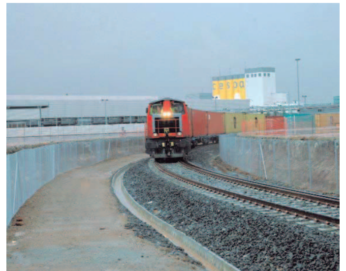
Las obras previstas proporcionarán un acceso ferroviario independiente y con capacidad suficiente en la ampliación sur.
